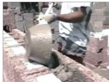
Заполняем бетоном по четыре ряда
