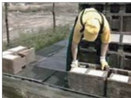
Устанавливаем опорные блоки
