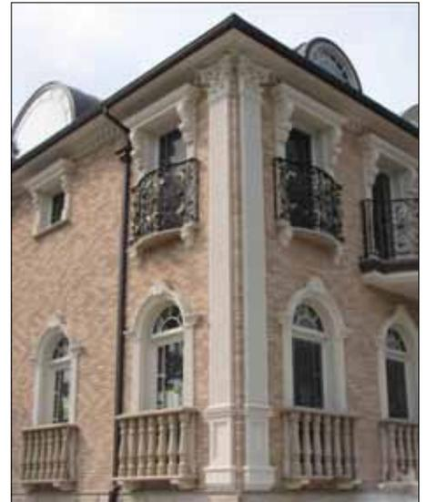
Предлагаемый художественный эскиз, без каких-либо конструкторских изменений. Установленные арки, окно продлено вниз, сделаны фальшь балюстрада, консоль. Все элементы прикреплены на фасад при помощи клея по кирпичу. Штыки обработаны полиуретановым герметиком белого цвета.
