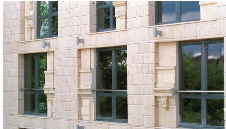
Облицовка фасада. Хилков переулок. Москва
