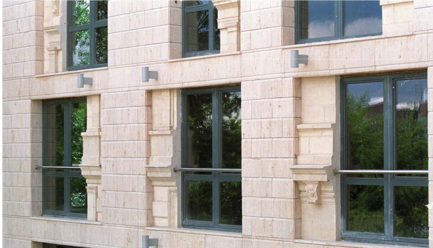
Облицовка фасада. Хилков переулок, Москва
