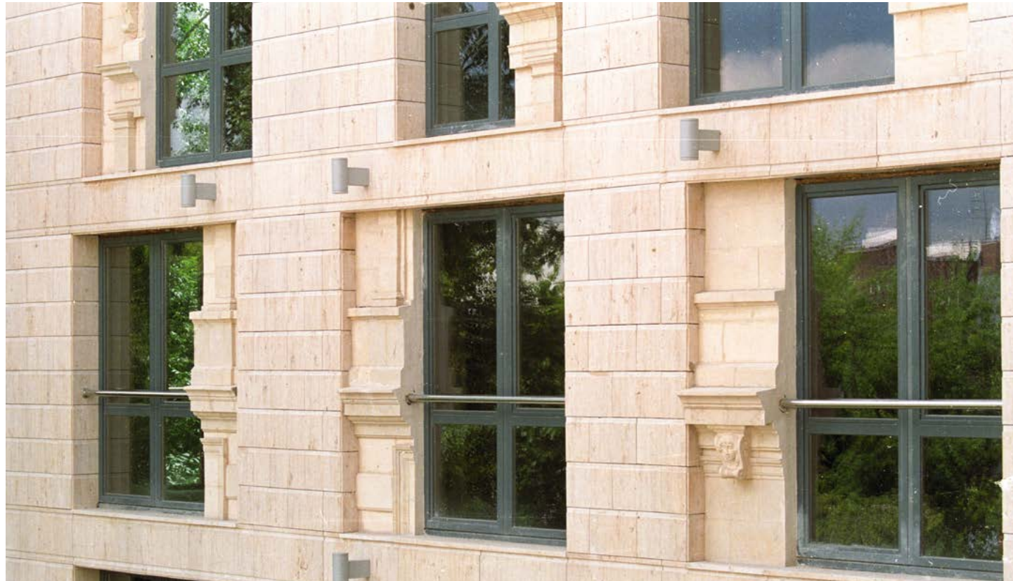
Облицовка фасада. Хилков переулок, Москва
