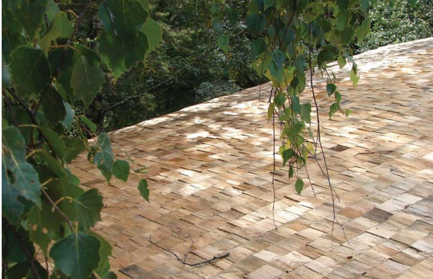
Далее производится торцовка пиловочника на пеньки заготовки необходимой длины и удаление заболони, молодой, быстрогниющей части древесины. Из пеньков заготовок методом ручной проколки, расщепляя их, получается дощечка-щепка, из которой в дальнейшем и происходит конечный результат – деревянная черепица. Почему так важна именно ручная проколка заготовок?
