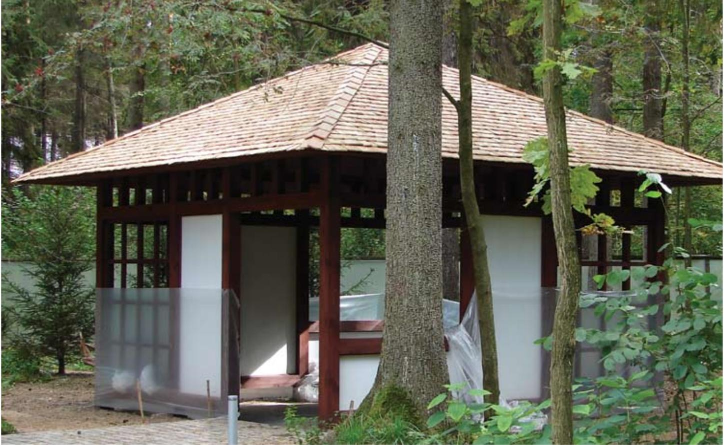
вой кровли. По заявлению немецких специалистов, сколько градусов составляет наклон крыши, столько лет прослужит кровля. Секрет долговечности гонтовой кровли заключается как в самом материале, так и в технологии его укладки. Гонт укладывается на крышу трехслойно, на фасад и кровлю беседок достаточно двух слоев.
