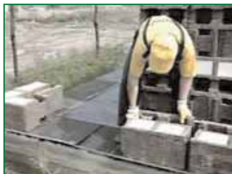
Устанавливаем опорные блоки
