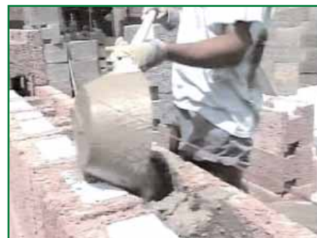
Заполняем бетоном по четыре ряда
