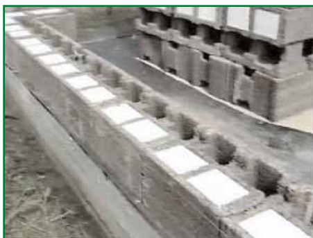
Выставляем блоки первого ряда, затем блоки последующих рядов
