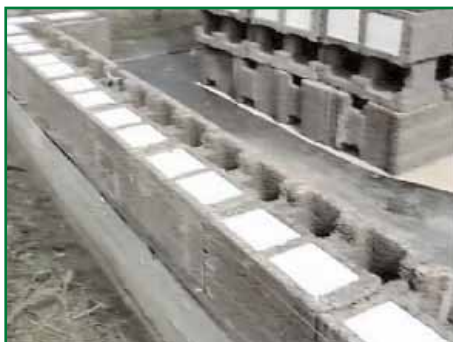
Выставляем блоки первого ряда, затем блоки последующих рядов
