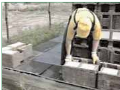
Устанавливаем опорные блоки
