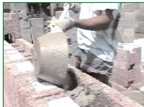
Заполняем бетоном по четыре ряда
