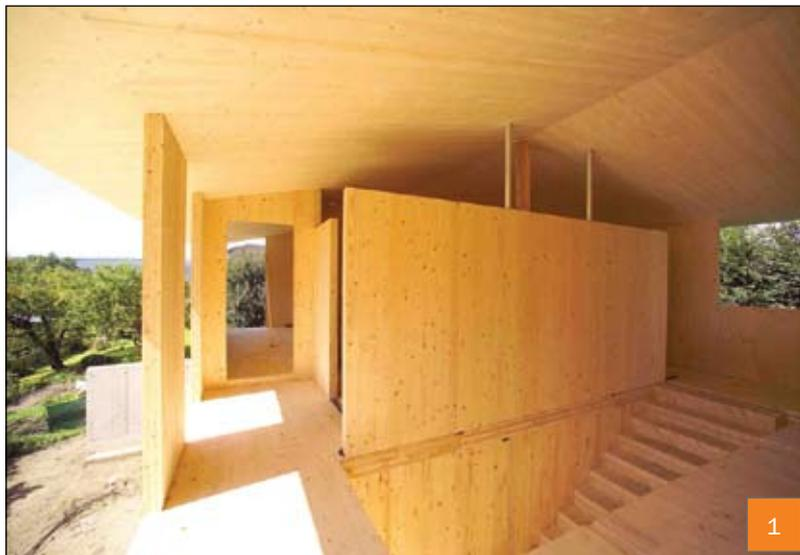
Главная изюминка технологии «Баварского дома» в том, что его несущие стены, перекрытия и даже кровля собираются панелями шириной до 3м, длиной до 16,5м и толщиной от 0,1 до 0,5м, изготовленными из массива дерева хвойных пород – технически просушенные доски, уложенные и проклеенные крест-накрест.
