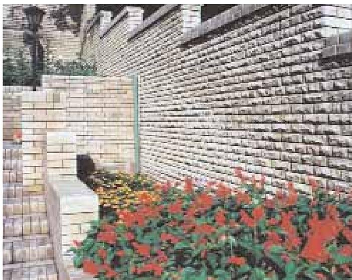
**Декорирование «под дикий камень».** Гиперпрессованный кирпич, в отличие от природного камня, имеет однородную плотность. Благодаря этому получается долговечная лицевая поверхность, имитирующая натуральный камень и при этом по форме имеющая размеры облицовочного кирпича.
