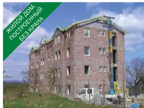
тепловая инерционность (теплоаккумулирующая способность) стен дома благодаря наличию массивного бетонного ядра. В сочетании с высокими теплоизолирующими характеристиками высокая тепловая инерционность конструкции дома позволяет существенно снизить затраты на отопление зимой и на кондиционирование летом. По уровню тепловой инерции дом из DURISOL подобен дому из кирпича, но при этом стены в 2 и более раз тоньше и легче традиционных, кирпичных, что позволяет также снизить стоимость фундаментов.
